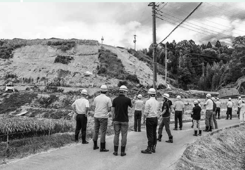
川原井表場での土砂崩れ現場視察の様子
